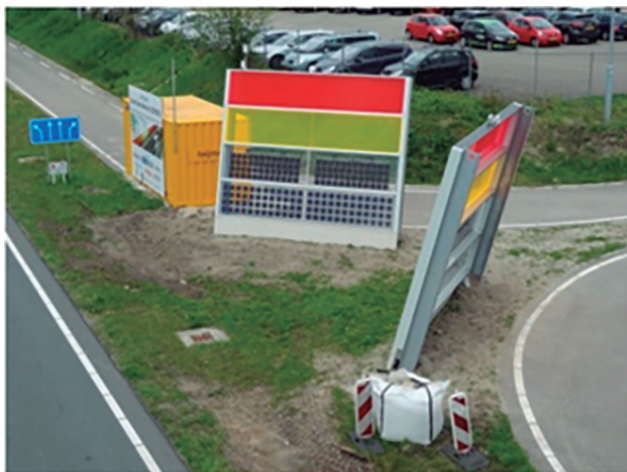
Figura 10 – Fotografias dos protótipos das barreiras sonoras. Adaptado, com permissão, da ref. [57].
